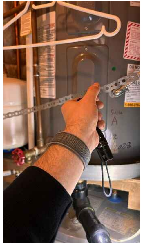
Unhooked seismic strap
