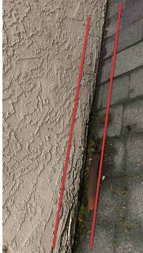
Add step flashing
