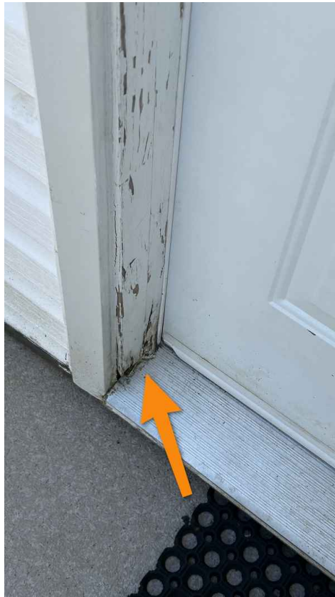
Back Door Frame Rotting
